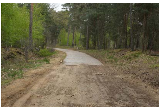
De militaire weg is op vele plaatsen in slechte staat. Dit masterplan stelt voor de militaire weg te herstellen in zijn oorspronkelijke materialiteit (uitgewassen beton).
